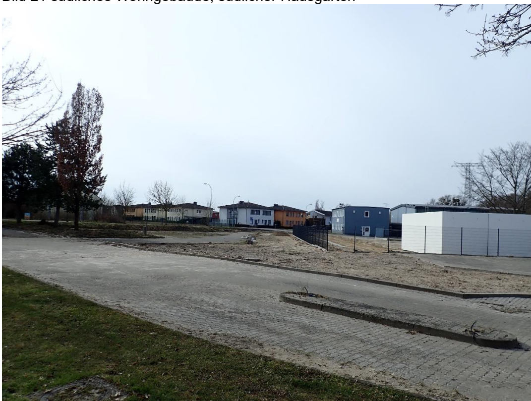
Bild 22 Garagencaree und Möbelbörse vom Osten (Ihlenfelder Straße)
