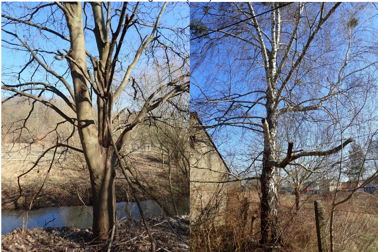
Bild 13 Blick Ahorn westlich des Hausgartens (PBG) und Birke am Gehöft (ODE) mit Astabbrüchen
