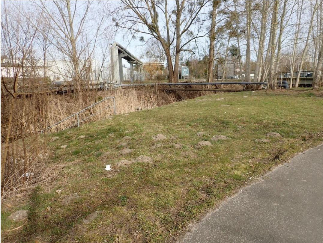
Bild 25 Datze südlich der Ihlenfelder Straße mit Fernwärmeleitung, das UG quert
