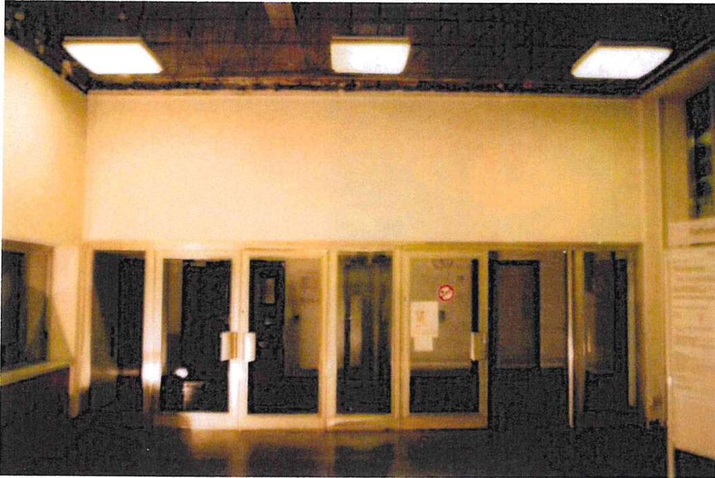
Ab. 5, Neubrandenburg, Rathaus, Foyer, links, Nordseite, mit Tapetenlagen überklebtes Wandbild, Zustand ca. 1991 bis 1999, Aufnahme A. Starke, 1998.
