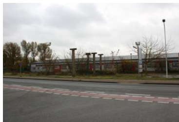
Blick auf die Bebauung südlich der Ihlenfelder Straße (südlicher Standortbereich) mit unattraktivem Erscheinungsbild an einer der Hauptein-/ausfallstraßen der Stadt.
