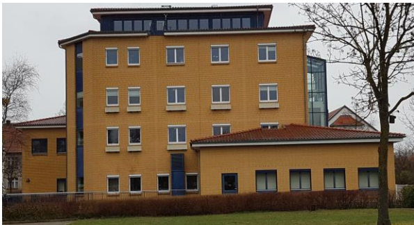
Greifstraße 107 - Blick aus S
