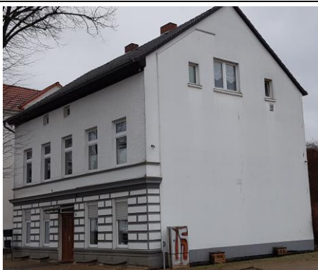
Ihlenfelder Str. 6 - Blick aus SW
