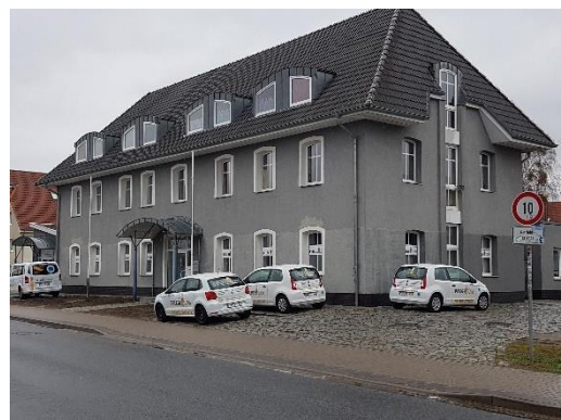
Johannesstraße 8 - Blick aus SO
