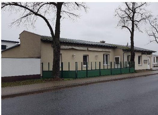
Johannesstraße 11 - Blick aus SW
