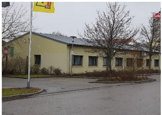
Johannesstraße 16 - Blick aus
