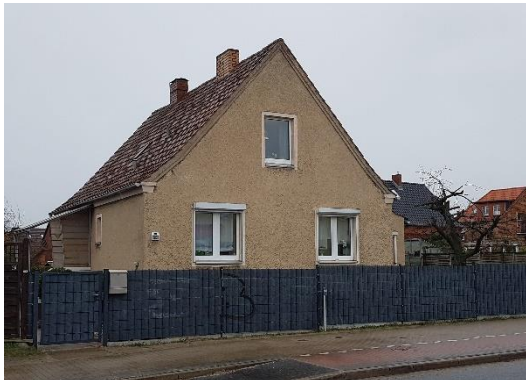
Johannesstraße 20 - Blick aus SW
