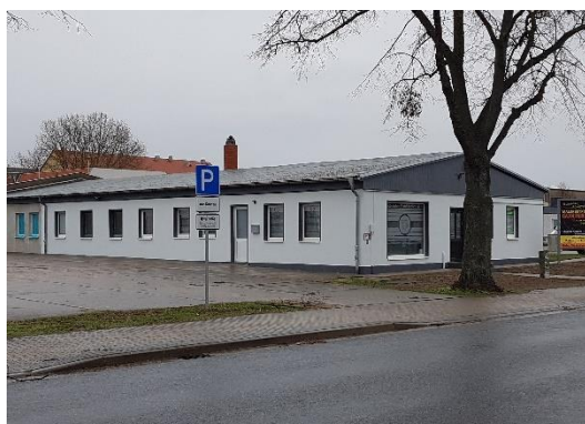
Johannesstraße 14 - Blick aus SW
