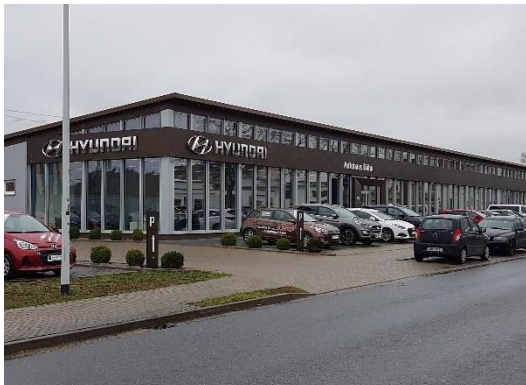
Johannesstraße 13 - Blick aus NO
