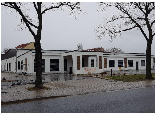
Johannesstraße 12 - Blick aus SW
