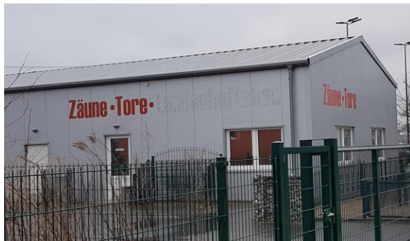
Johannesstraße 13c - Blick aus NO
