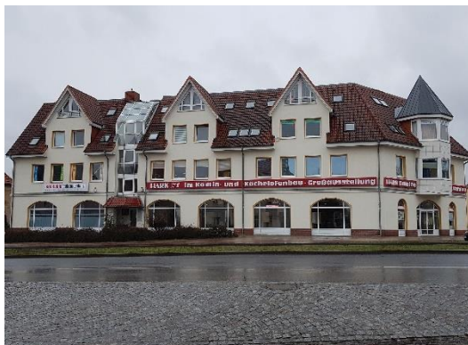
Demminer Str. 5 - Blick aus W
