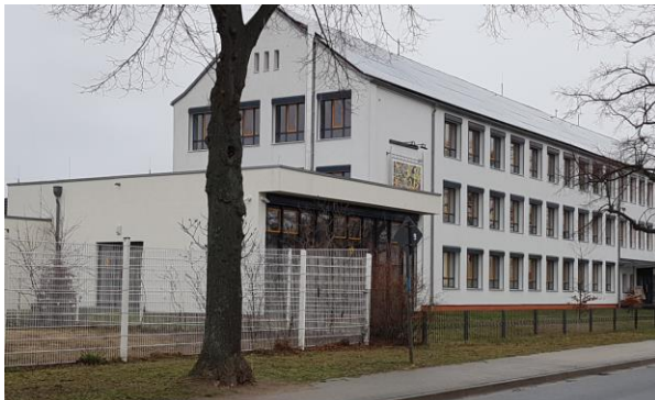
Johannesstraße 18 - Blick aus SW
