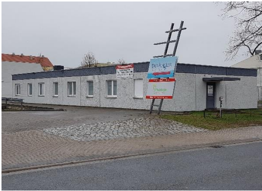
Johannesstraße 14a - Blick aus SW
