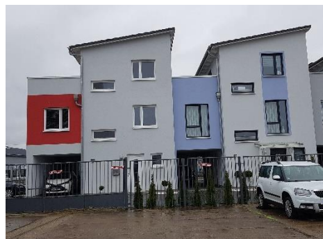
Johannesstraße 10 / 10a - Blick aus O
