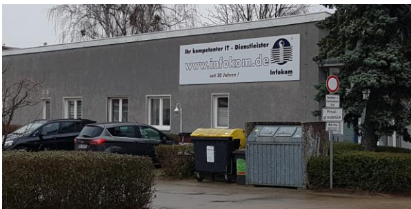
Johannesstraße 8a - Blick aus SW
