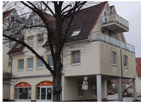
Ihlenfelder Str. 8a (Süd) - Blick aus SW
