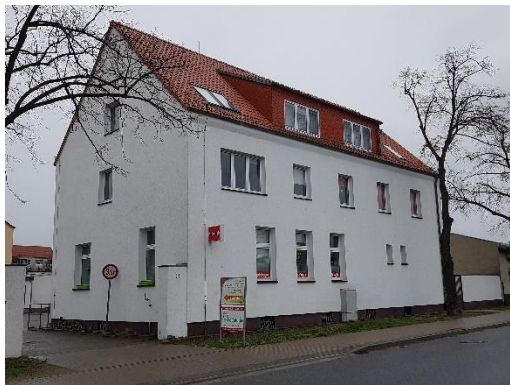
Johannesstraße 11 - Blick aus SW
