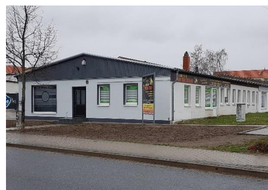
Johannesstraße 14- Blick aus SO
