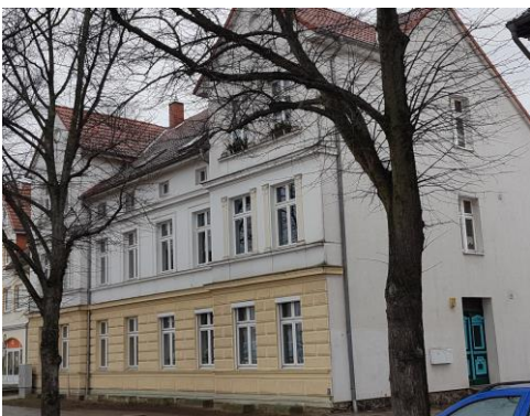
Ihlenfelder Str. 8 / 7 - Blick aus SW
