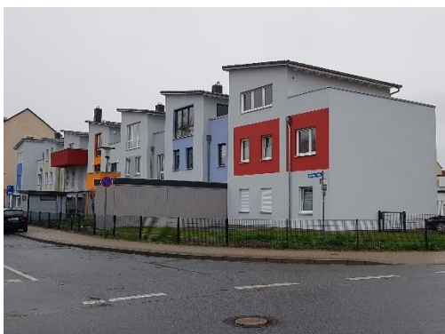
Johannesstraße 10 - 10f - Blick aus SW
