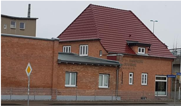
Johannesstraße 1 - Blick aus NO
