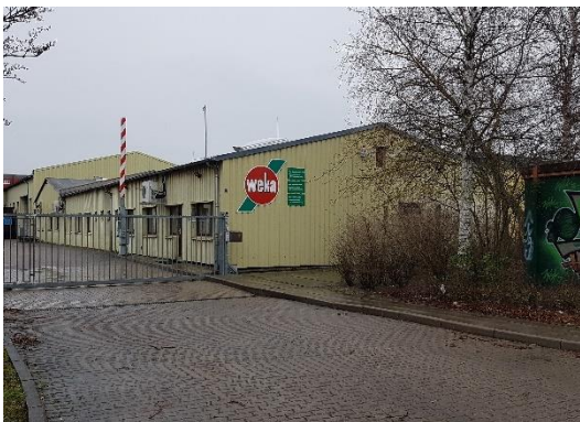
Johannesstraße 16 - Blick aus SW
