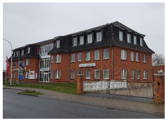
Johannesstraße 15a - Blick aus NW
