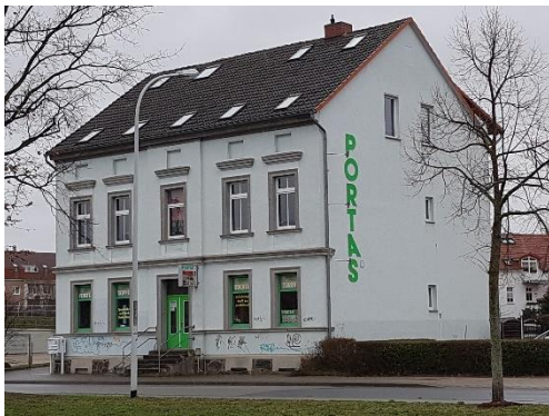
Johannesstraße 3 - Blick aus SO
