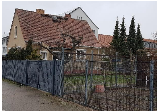
Johannesstraße 20 - Blick aus SW
