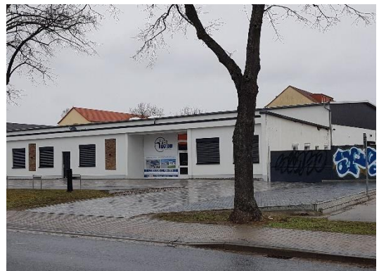
Johannesstraße 12 - Blick aus SO
