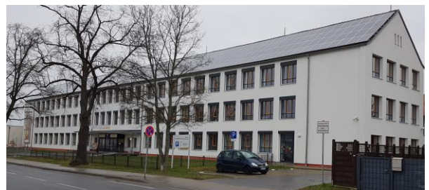
Johannesstraße 18 - Blick aus SO
