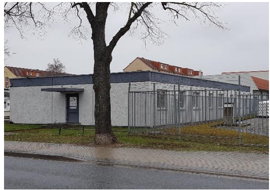
Johannesstraße 14 - Blick aus
