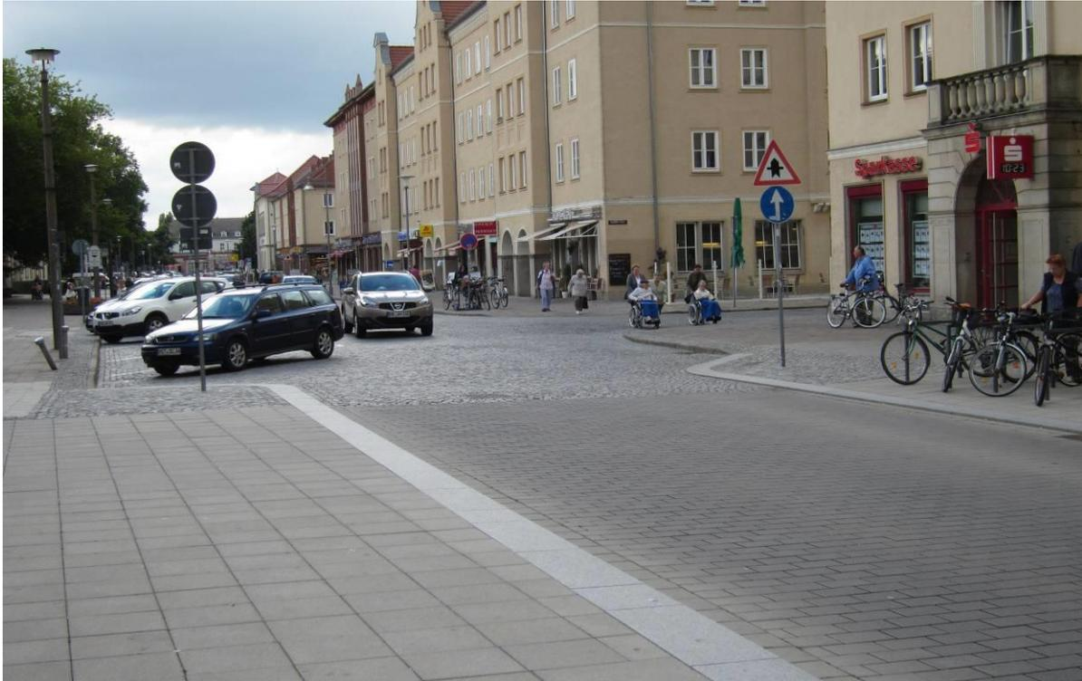
Abb. 5 Übergang von konventionellem Pflaster auf „leises“ Pflaster in der Stargarder Straße
