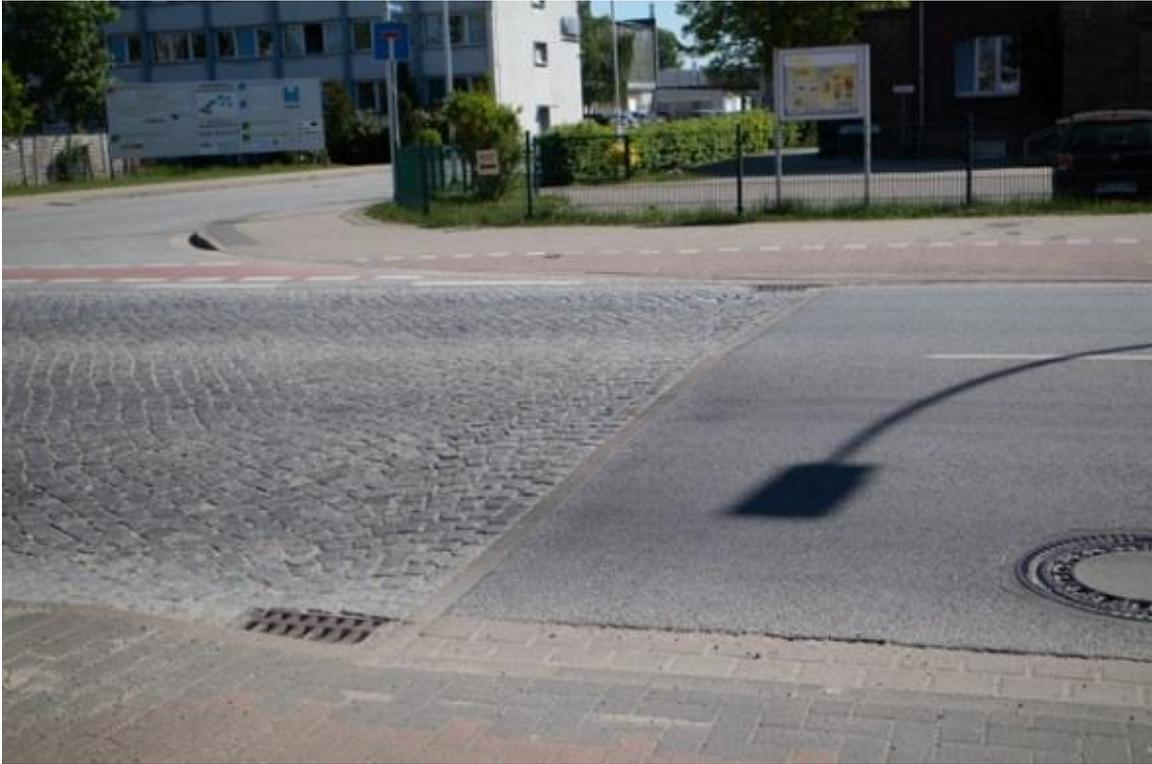
Abb. 6 Übergang von konventionellem Pflaster auf Asphalt in der Sponholzer Straße
